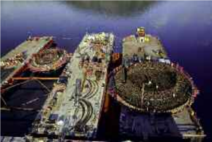
Errichtung der Tresfjordbrücke © Bilfinger Tresfjordbridge
