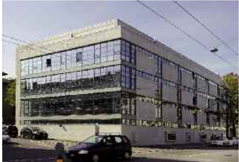
Erscheinungsbild nach erfolgter Sanierung © Jean-Claude Jossen/Jansen AG
