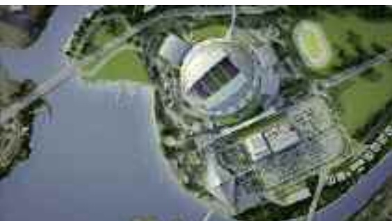
Dach im Singapore Sports Hub © Tekla Corporation
