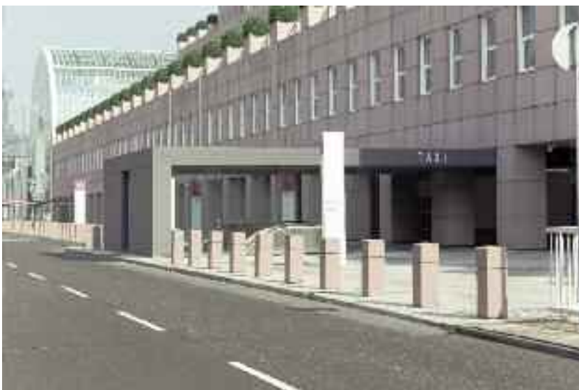
Treppe und Eingangsbereich von Halle 9 © Ingo Schrader
