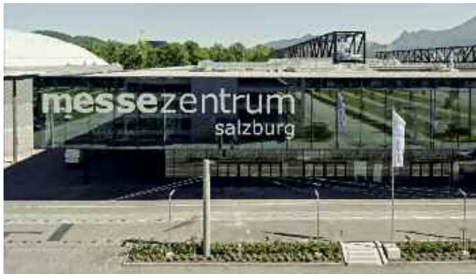
Fassadenfront entlang dem Messeboulevard © Angelo Kaunat
