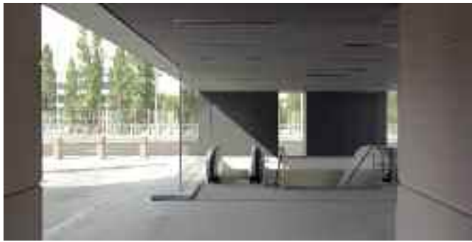
Treppenabgang und Zugang aus dem Foyer © Ingo Schrader
