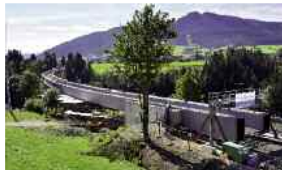
Erster Preis: Erneuerung des Wertachtalübergangs © Dr. Schütz Ingenieure
