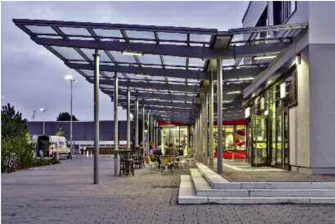
Verbindendes Element: Dachkonstruktion aus Stahl und Glas © Martin Duckek
