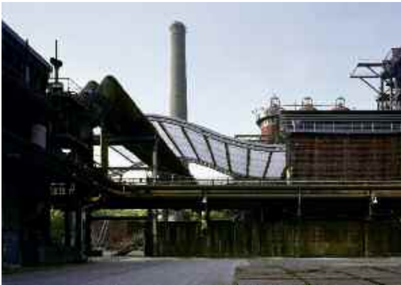
Dach der Gießhalle im Landschaftspark Duisburg-Nord © planinghaus architekten bda
