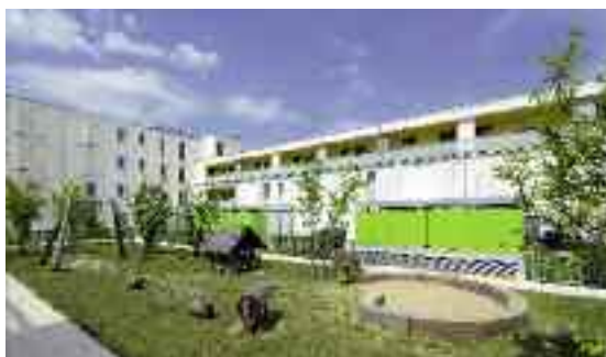
Integration der Tiefgaragenlüftungsschächte © Käuferle GmbH & Co. KG
