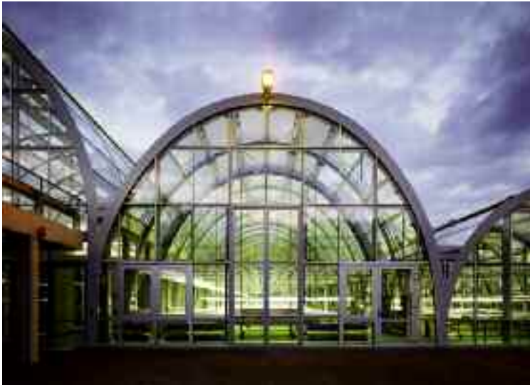
Staffelung der Baukörper nach Höhe © Christian Richters
