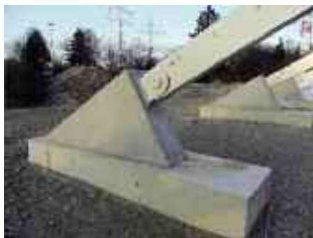
Bogenwiderlager: aufgesetztes Fertigteil und Pfahlkopfplatte in Ortbeton © AJG Ingenieure GmbH
