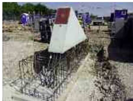
Bogenwiderlager: aufgesetztes Fertigteil und Pfahlkopfplatte in Ortbeton © AJG Ingenieure GmbH
