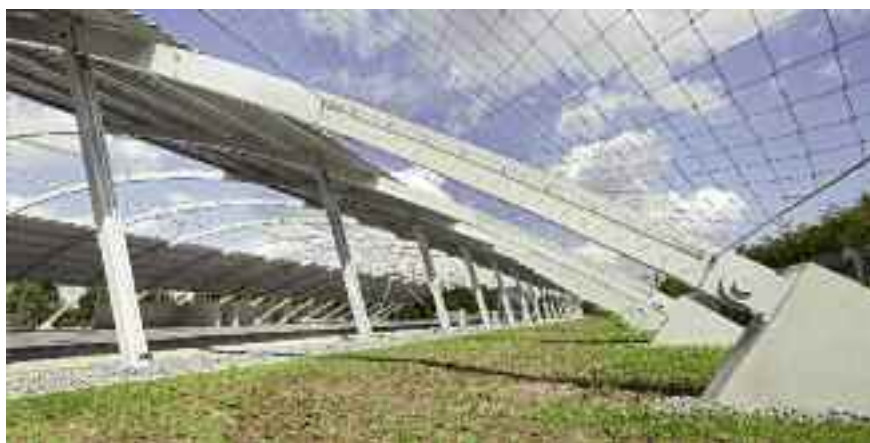
Bogenträger, Stützstreben und Seilnetz © Frank Aussieker
