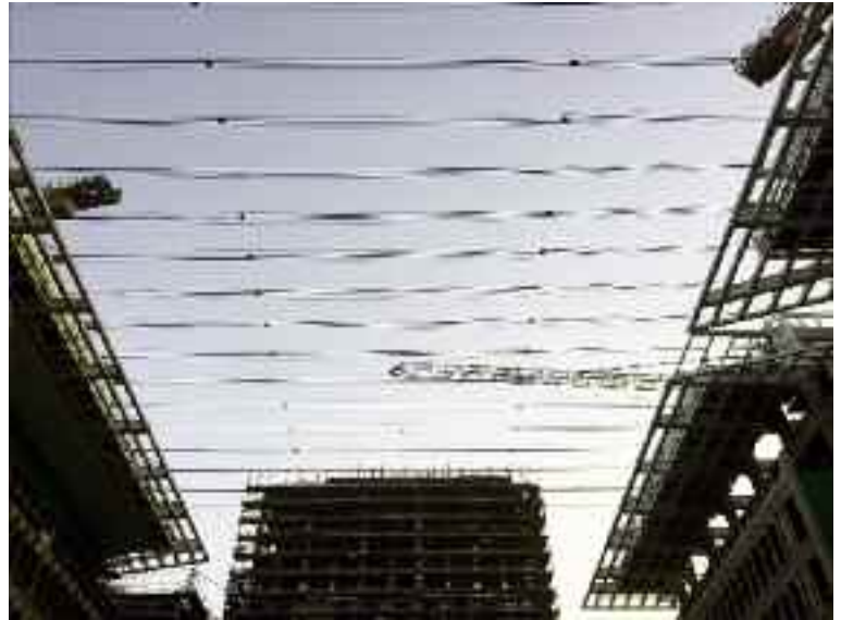
Errichtung des Heart of Doha in Katar
