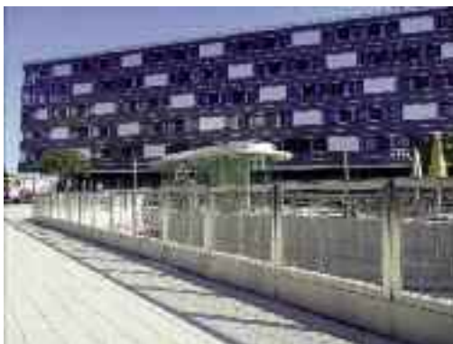
Tiefgarageneinfahrt am Stadtplatz in Wolfsburg © Dorstener Drahtwerke H. W. Brune & Co. GmbH
