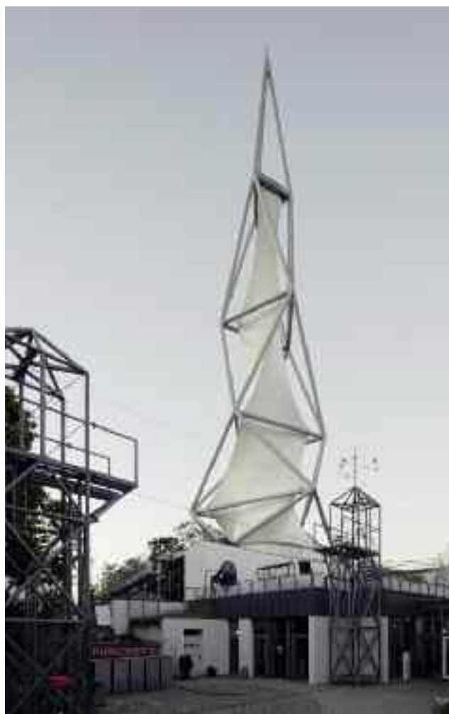
Stahlurm mit innenliegender Kaleidoskophülle © Robert Mehl
