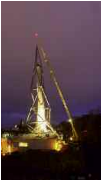
Montage der Membranhelix per Autokran © Alexander Ring
