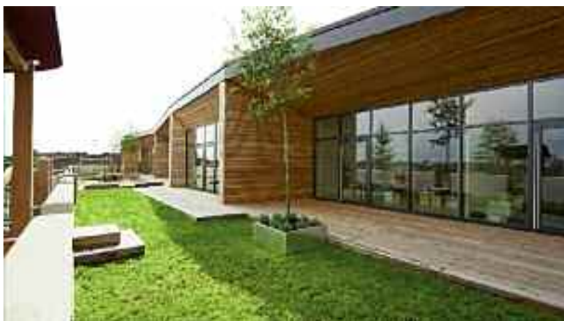
Holzfassade mit Panoramafenstern © querwärts Fotodesign
