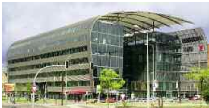
Deutsche Med in Rostock: entkoppelte Fassade und frei einteilbare Geschosse © DW Systembau GmbH
