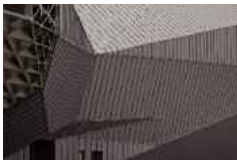
Doppelstehfalzdeckung ... © VM Zinc/Umicore Bausysteme GmbH
