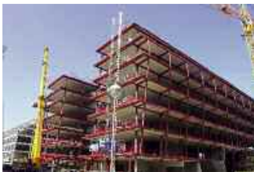
Deutsche Med in Rostock: entkoppelte Fassade und frei einteilbare Geschosse © DW Systembau GmbH
