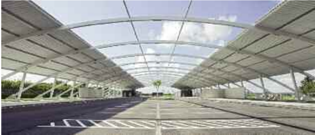
Struktur aus hintereinandergereihten Stahlbögen © Frank Aussieker
