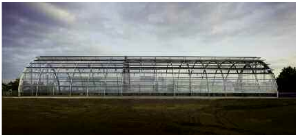
Konstruktion aus Stahlprofilen und Isolierglas © Christian Richters
