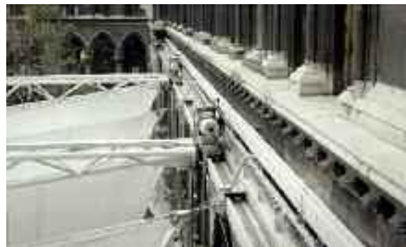
Randträger des Außendaches © Till Beckmann
