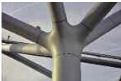
Verkleidung: 3-D-Druck-Bauteile © Adrian Priestmann/Vector Foiltec Ltd.
