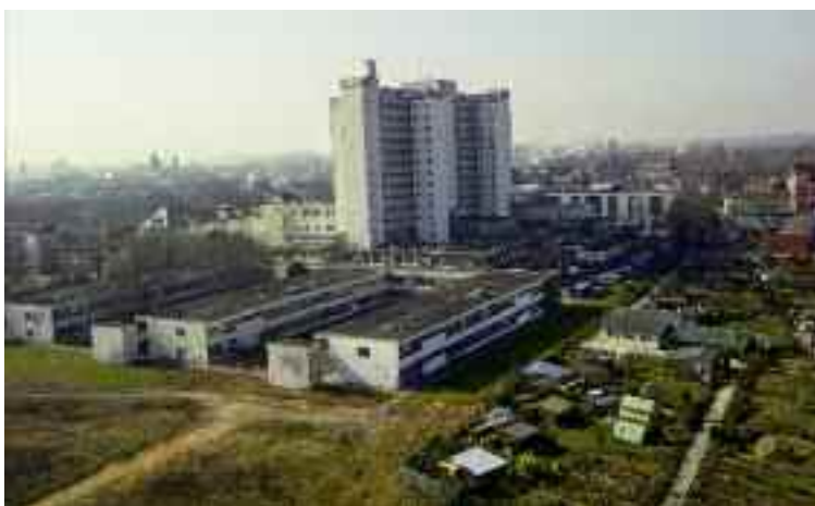
Blick aus dem Fenster: Bestandsgebäude und Neubauareal © Paul Müller/Verlagsgruppe Wiederspahn
