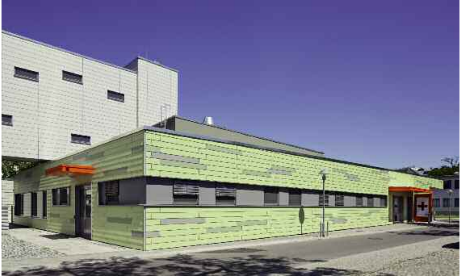
Notfallaufnahme mit Eingang zur Ambulanz, dahinter das Brückengebäude mit dem Bettenaufzug © BBR/Andreas Meichsner
