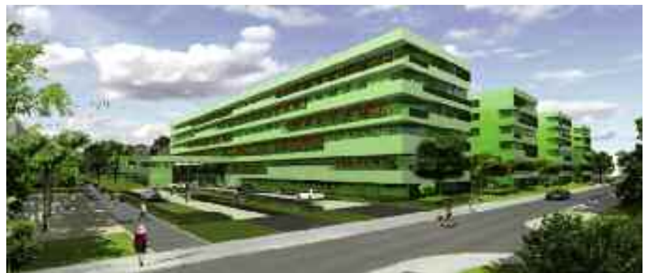
Ansicht von Fassade und Haupteingang © wörner traxler richter/ZEG GmbH
