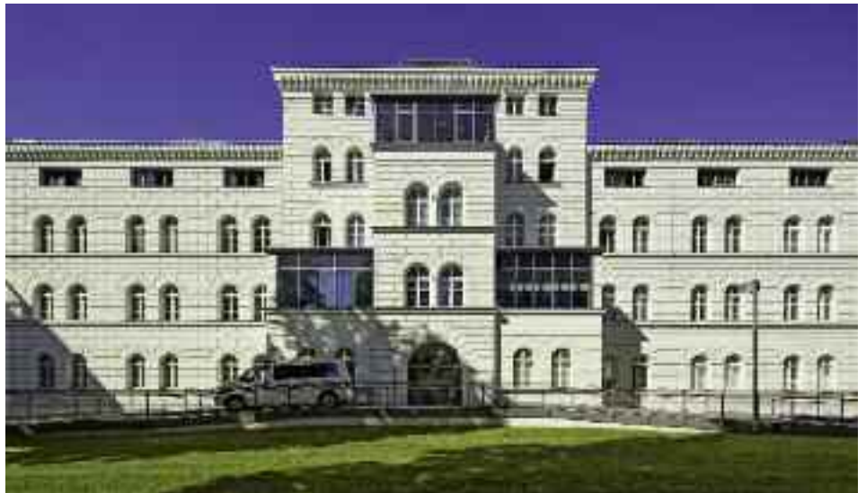
Rückwärtige Fassade des denkmalgeschützten Ursprungsbaues © BBR/Andreas Meichsner
