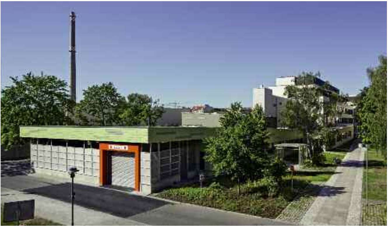
Kopfseite der Notfallaufnahme mit dem vorgelagerten überdachten An- und Abfahrbereich für die Rettungswagen © BBR/Andreas Meichsner
