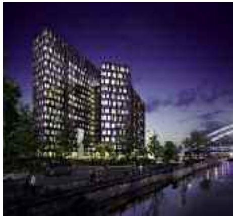
(Künftiges) Erscheinungsbild bei Dunkelheit © CA Immobilien Anlagen AG
