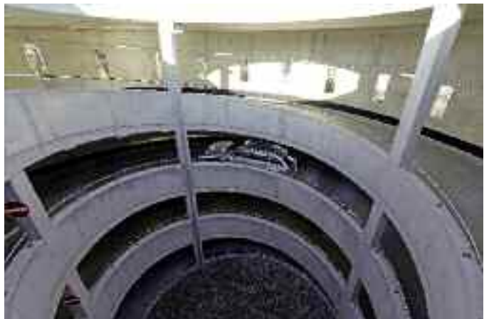
Auf- und Abfahrtspindel aus Sichtbeton © Firmengruppe Max Bögl
