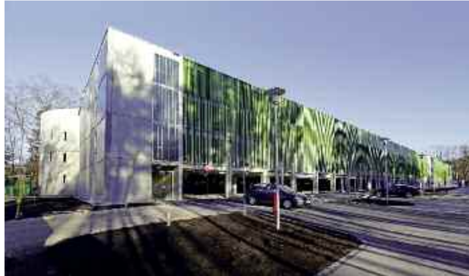
Viergeschossiges Parkhaus in Betonfertigteilsystembauweise © Firmengruppe Max Bögl
