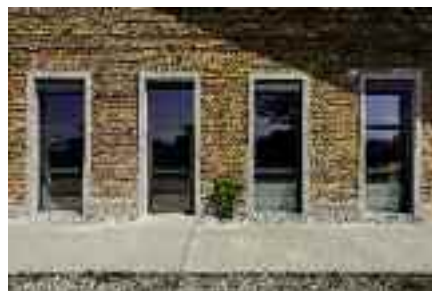
Stahlprofilssysteme (auch) an den Giebelseiten © Erich Hussmann/Jansen AG
