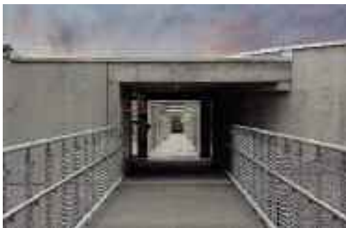
Steg zur barrierefreien Erschließung © Firmengruppe Max Bögl
