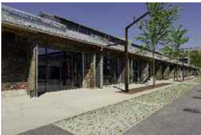
Längsfront: Backsteinmauerwerk und Originaltore © Erich Hussmann/Jansen AG
