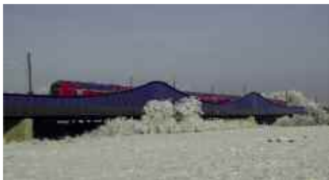
Allerbrücke bei Verden nach Fertigstellung © Erich Schwinge
