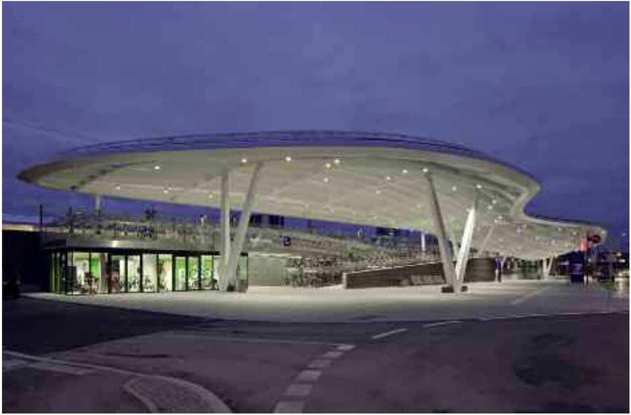
Dach der neuen Station als markantes Stadtzeichen und Eingangsbauwerk in die Bahnhofspassage © Angelo Kaunat
