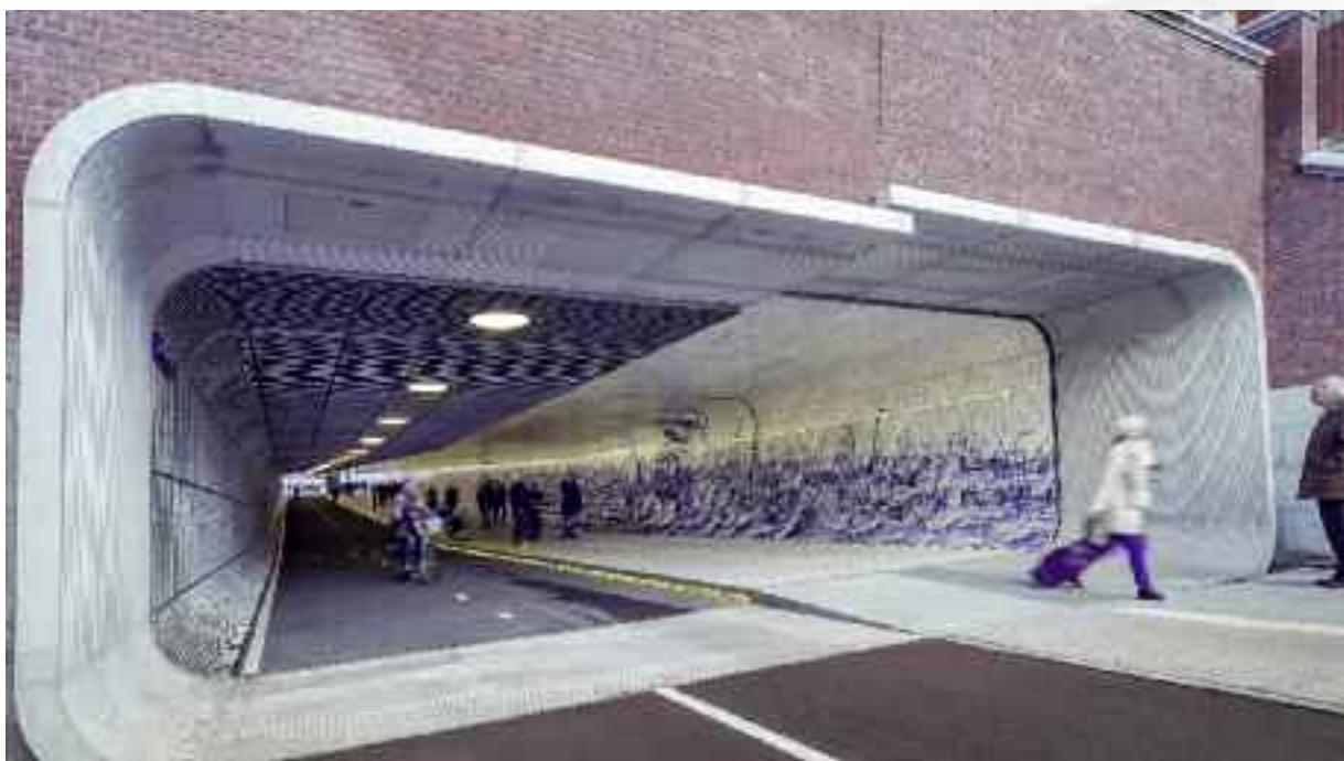
Stadtseitiger Eingang in den Tunnel mit getrennter Radfahrer- und Fußgängerzone © Jannes Linders
