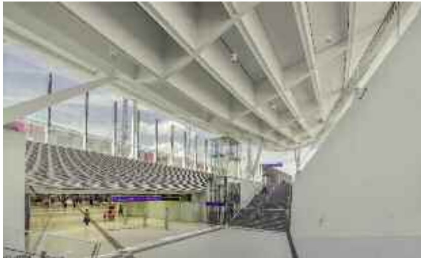
Erschließung der Bike & Ride Station © Helmut Pierer
