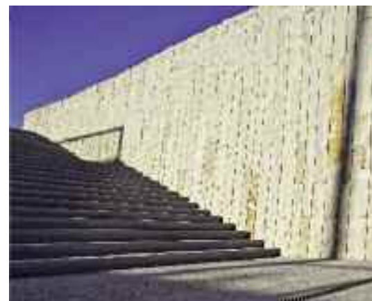
Haupterschließung in Brückennähe © Hager Partner AG
