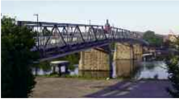
Alte Mainbrücke Zellingen nach Ertüchtigung © Büchting + Streit AG/Hochreither Vorndran Ingenieurgesellschaft mbH
