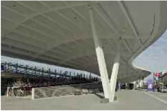
Rampe zur doppelstöckigen Abstellenebene © Angelo Kaunat
