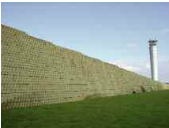
Schutzbauwerk (kurz) nach Fertigstellung © Betoconcept-Unternehmensgruppe
