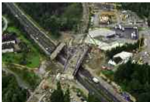
Brücke bei Kramsach im Bauzustand © ÖBB-Infrastruktur AG
