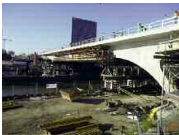
Errichtung der Erdberger Brücke am Knoten Prater © ASFiNAG Baumanagement GmbH
