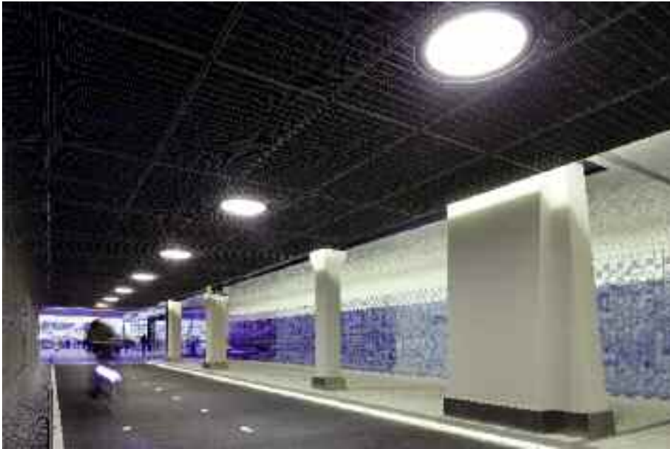
Stützpfeiler am Ausgang zum Hafenbecken © Jannes Linders
