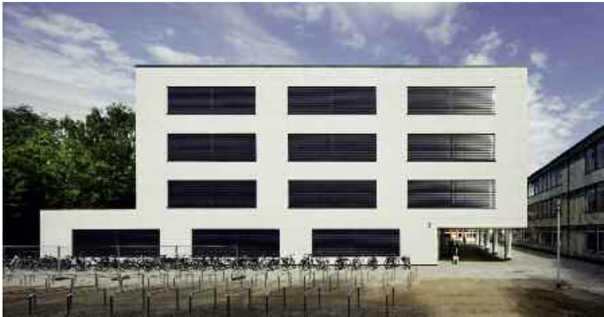
»Verschobene« Obergeschosse als ein Charakteristikum © Werner Huthmacher
