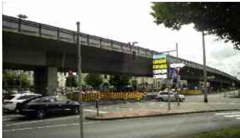
Beginnende Ertüchtigung der Brücke Hildesheimer Straße © Michäel Provost/Sweco Belgium nv
