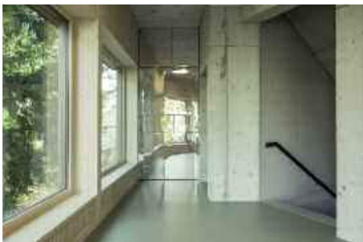
Erschließungskern aus Stahlbeton © Dominique Marc Wehrli
