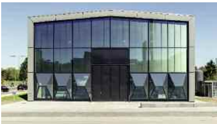
Südfassade als (technischer) Blickfang © Schüco International KG
