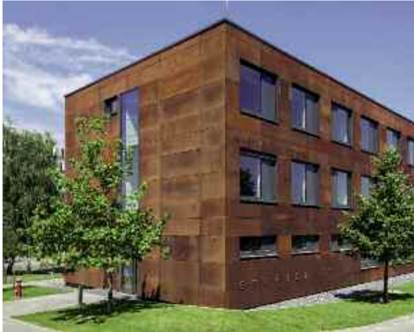
Fassade aus Cortenstahl in verschiedenen Rosttönen © Inros Lackner SE
