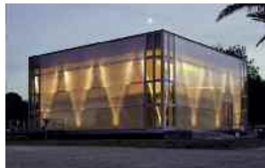
Cubity beim Solar Decathlon 2014 in Versailles © Thomas Ott/Nassauische Heimstätte Wohnungs- und Entwicklungsgesellschaft mbH
