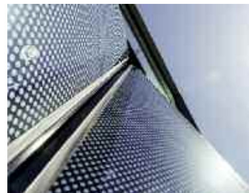
Sonnenschutz: aufgedrucktes Punktraster © Schüco International KG
