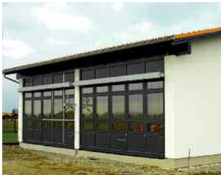
Versuchsgebäude des Fraunhofer-Instituts für Bauphysik am Standort Holzkirchen für Untersuchungen zu Raumklima und Luftqualität in Klassenzimmern © Fraunhofer-Institut für Bauphysik
