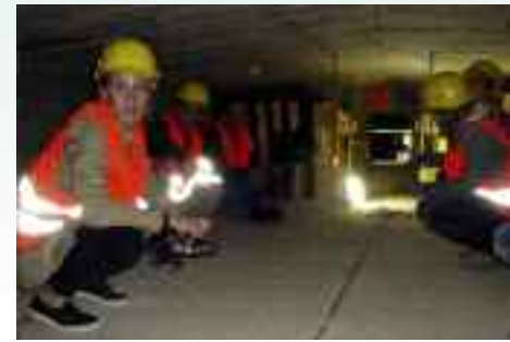
Arbeitshöhe im Hohlkasten © Michäel Provost/Sweco Belgium nv
