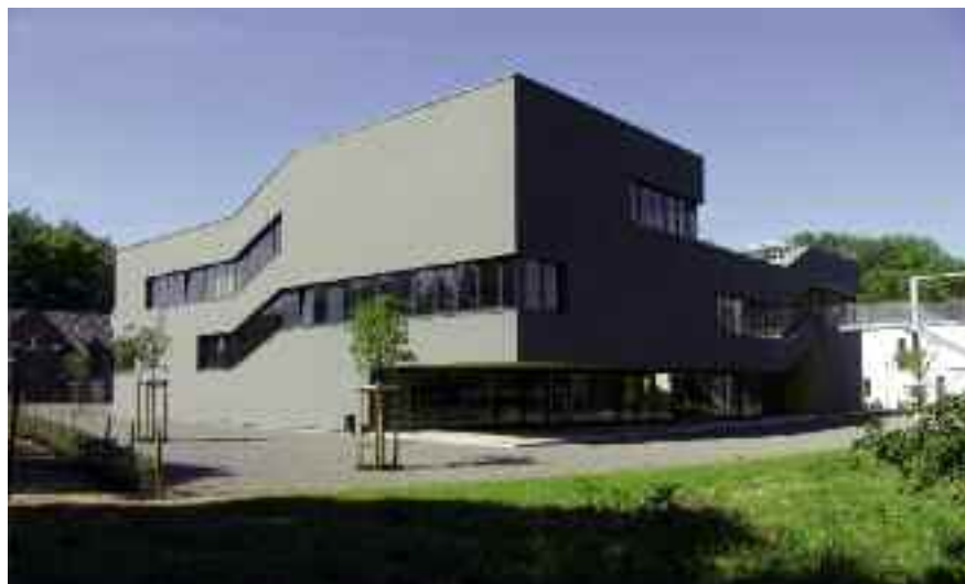
Science College im Bildungszentrum Overbach: Projekt im Forschungsvorhaben »EnEff:Schule«, wissenschaftliche Begleitung durch das Fraunhofer-Institut für Bauphysik © Fraunhofer-Institut für Bauphysik
