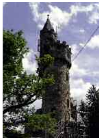
Bauwerk (noch) mit Einrüstung © Deutsche Stiftung Denkmalschutz
