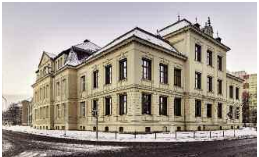
Saniertes Gebäude der früheren Zittauer Webschule am Altstadtring
