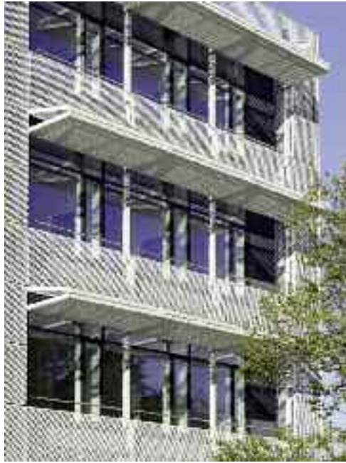
Fassade des Centrums für Schlaganfall- und Demenzforschung © Stefan Müller-Naumann
