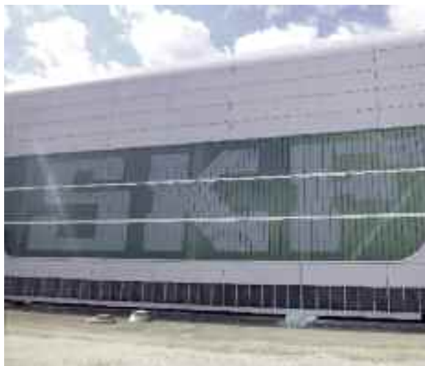
Gebäude (noch) im Bauzustand © nps tchoban voss GmbH & Co. KG
