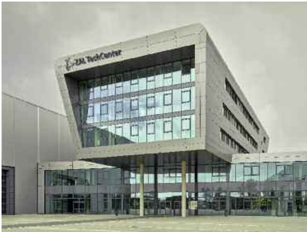
»Schwebender« Büroriegel als Erkennungszeichen © Klemens Ortmeyer
