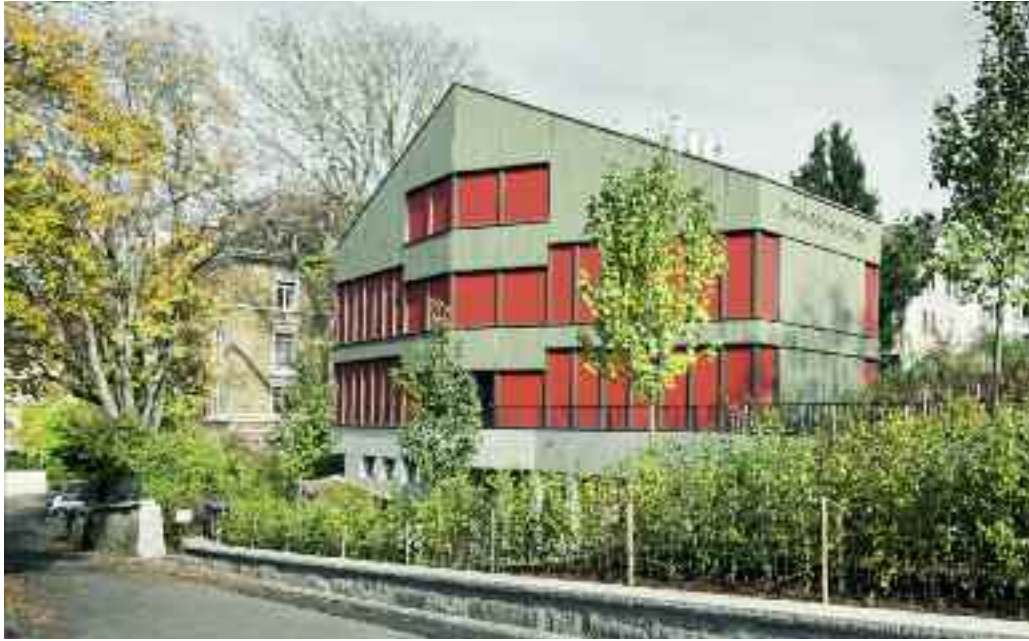
Erscheinungsbild (kurz) nach Fertigstellung © Dominique Marc Wehrli
