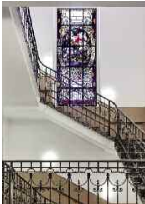
Treppenhaus mit Buntglasfenster und erhöhtem Bestandsgeländer © Michael Moser
