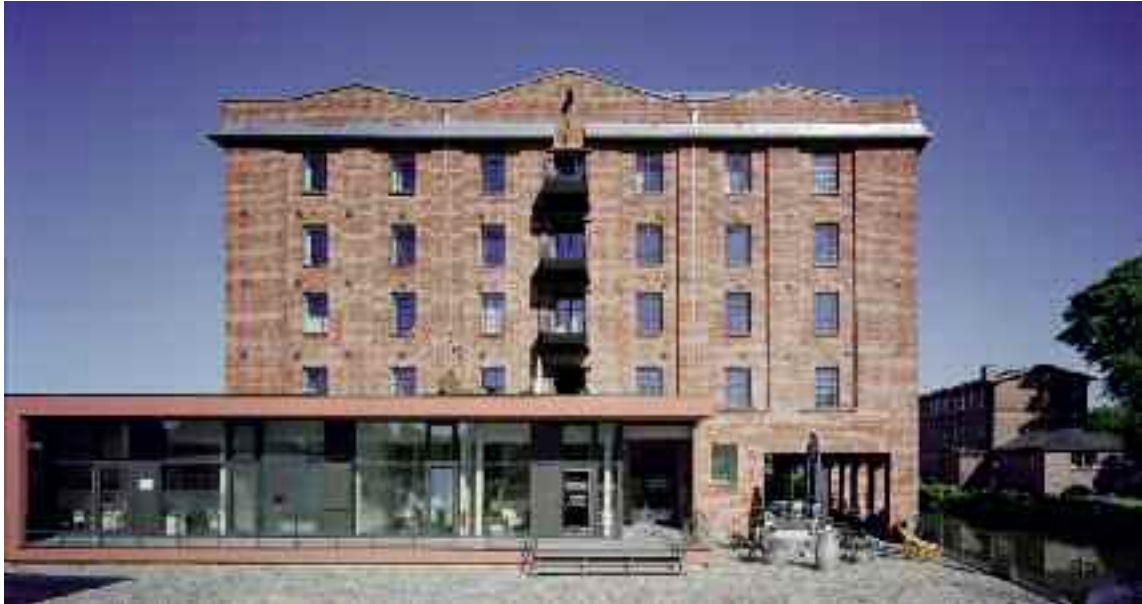
Erscheinungsbild nach Sanierung und Ergänzung © Markus Dorf Müller und Johanna Klier
