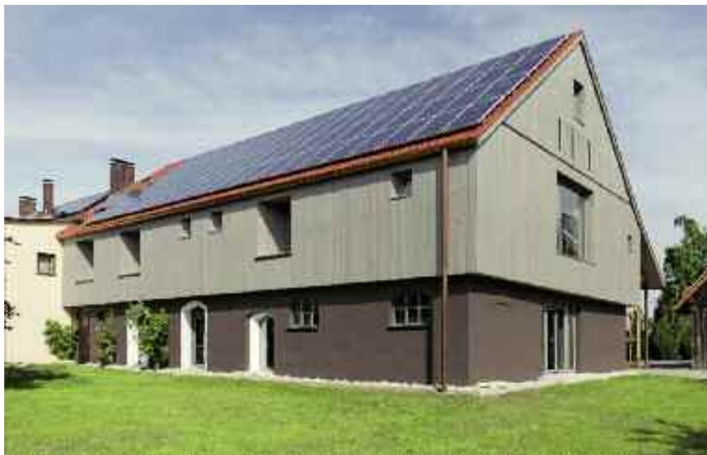
Erscheinungsbild nach Sanierung und Umbau © Berschneider + Berschneider
