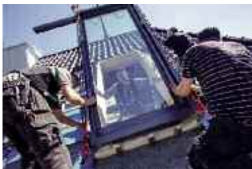
Einbau des Elementes samt zusätzlichem Sonnenschutzrollo © Amelingmeyer Metallbau GmbH
