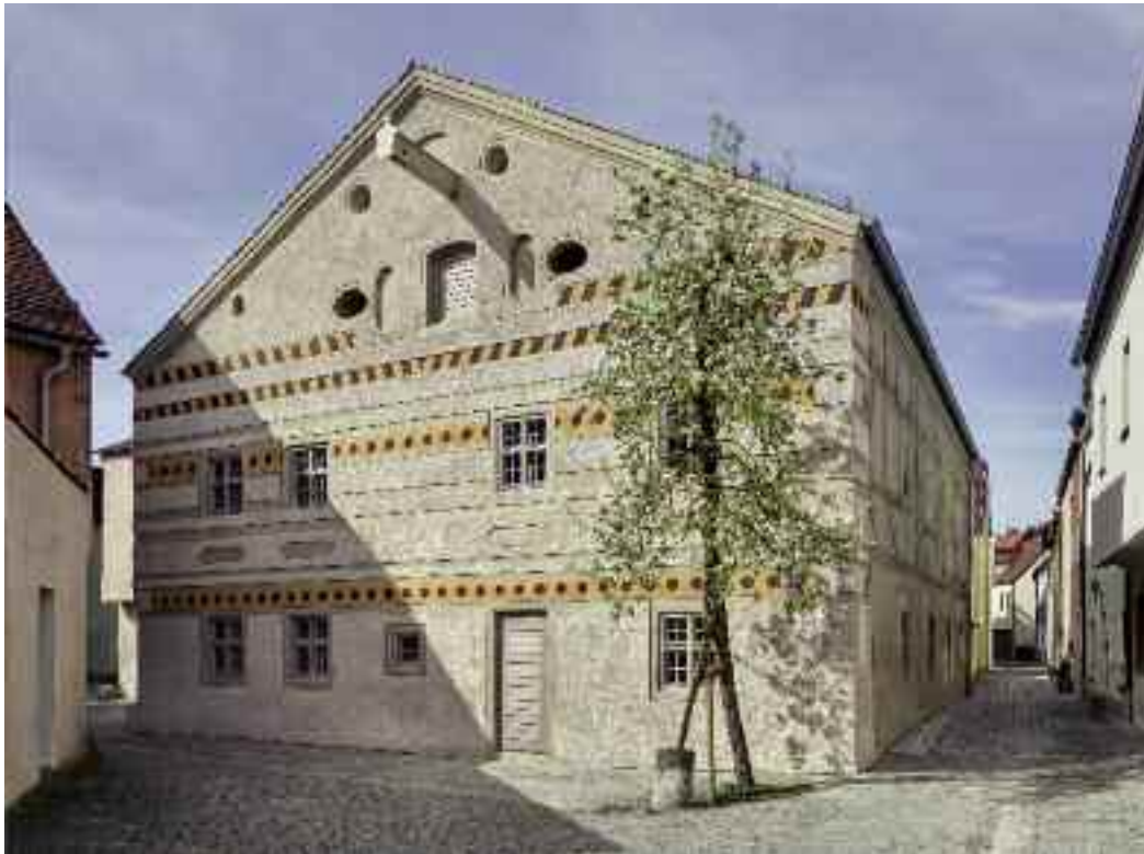
Ursprüngliches Fassadenbild nach Wiederherstellung © Erich Spahn
