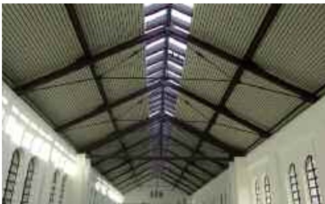
Unterspannte Konstruktion als Ausführungsbeispiel © Rudolf Hensel GmbH
