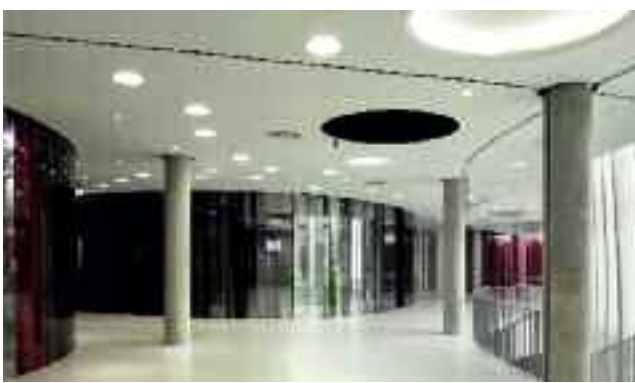
Gläserne Rauchschürzen in Treppenhäuser und Ausstellungsbereich © XTU architects/Julien Lanoo
