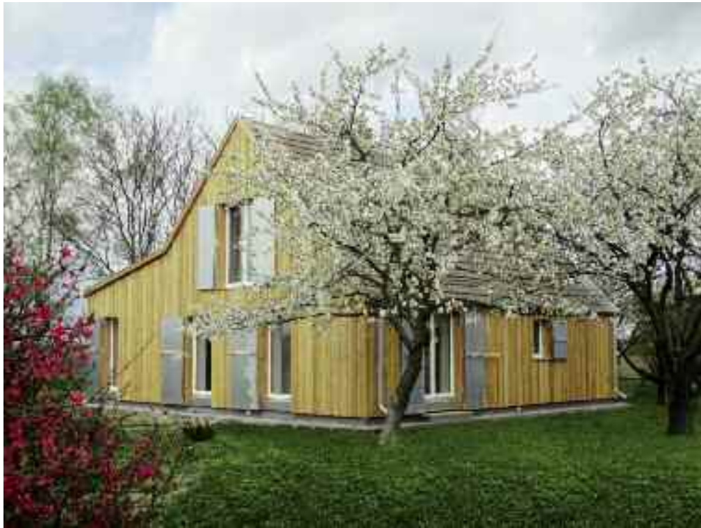
Refugium fernab der Großstadt nach Fertigstellung © Henrich Rauschnig
