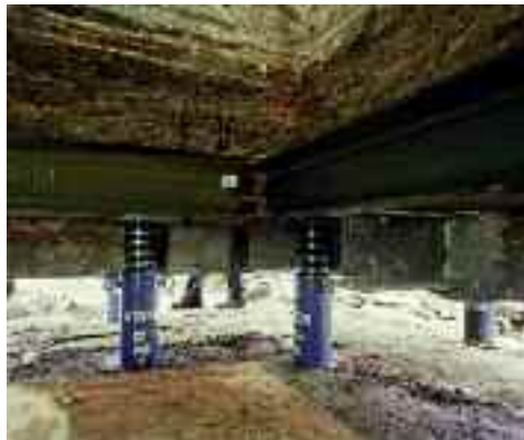
Hydraulische Anhebung des Gebäudes © KBNK Architekten GmbH/Markus Dorf Müller und Johanna Klier
