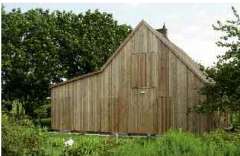
Fassade aus sägerauer Lärchenschalung © Henrich Rauschnig
