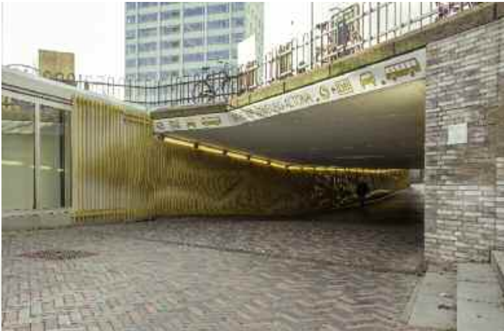
Auftakt zur (neugestalteten) Unterquerung nach Fertigstellung © Renner Hainke Wirth Architekten
