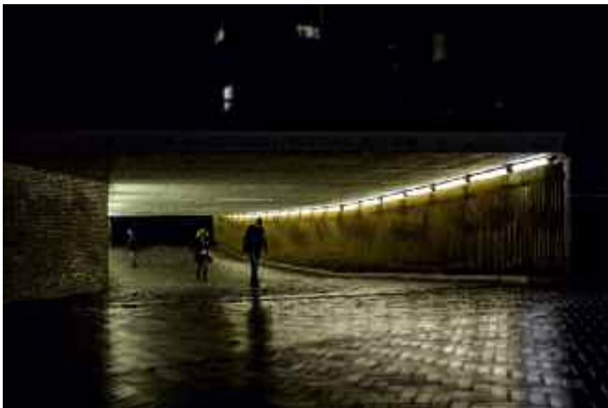
Tunnelbauwerk bei Dunkelheit © Renner Hainke Wirth Architekten
