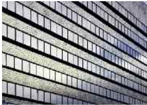
Ostfront mit geschliffenen Keramikfliesen © Oskar Dariz/Stahlbau Pichler GmbH
