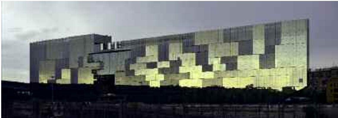
Westseite: Structural-Glazing-Elemente als Außenhaut-Elementfassade © Oskar Dariz/Stahlbau Pichler GmbH
