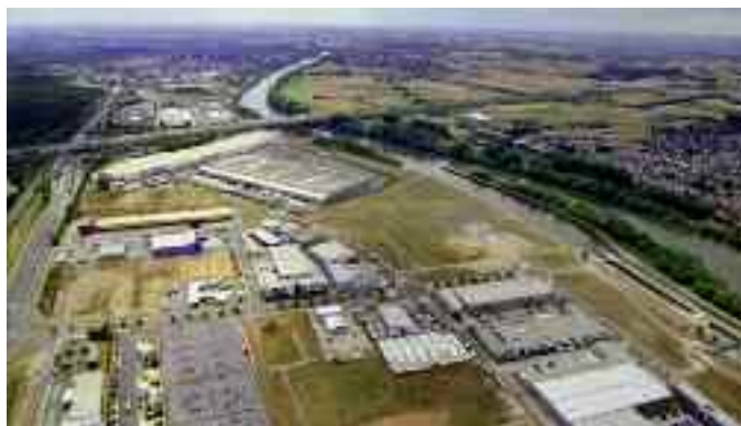
Mönchhof-Gelände in zentraler Lage am Main
