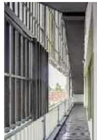
»Fassadenzwischenraum« im Detail © Michael Heinrich
