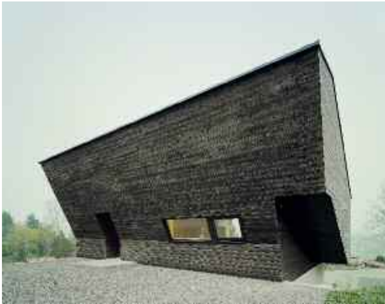
Rückfassade mit »Anschnitt« © Brigida González
