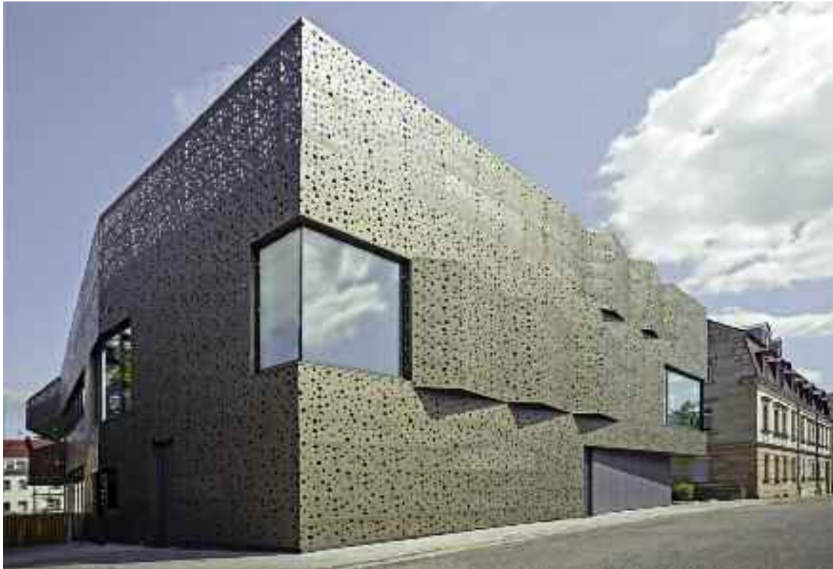
Lichtfilternde Außenhaut als gestaltprägendes Element © Wolfram Reuter/dürschinger architekten
