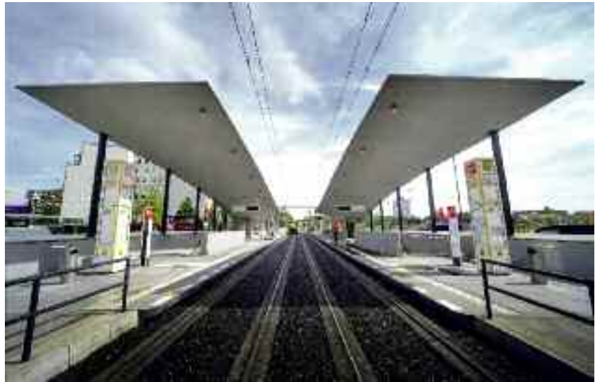
Dächer von geringer Bauhöhe und großer Leichtigkeit © Hanns Joosten/Liapor GmbH & Co. KG
