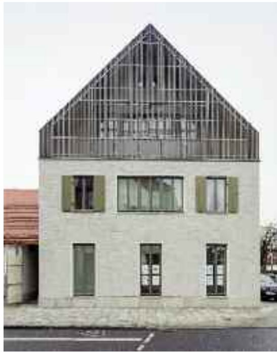
Auffaltbare Holzlamellenverkleidung am Giebel © Michael Heinrich
