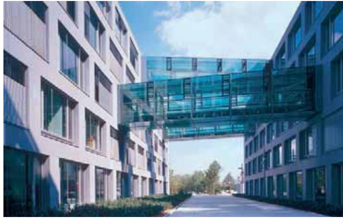
Verbindungsbrücken © Johannes Seyerlein
