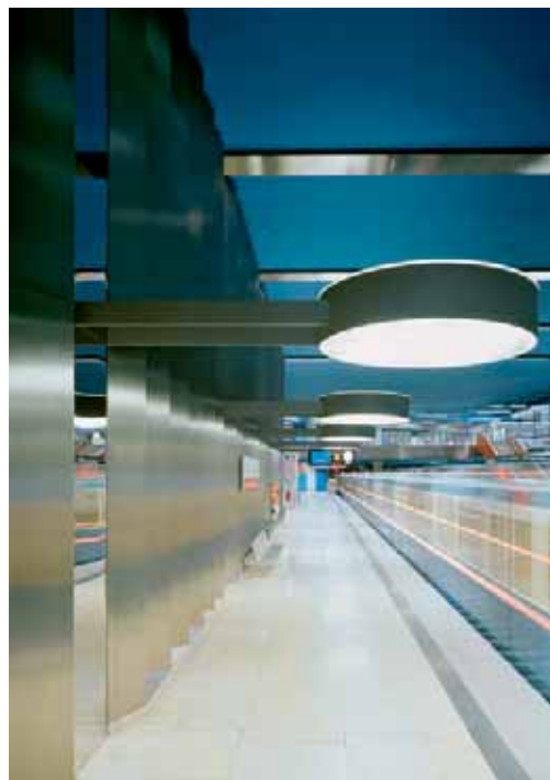
Bahnsteig U1; Beleuchtung © Oliver Betz
