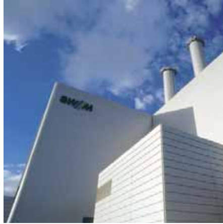
Trafogebäude © Massimo Fiorito
