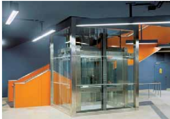
Aufzug und Treppenaufgang ins Sperrengeschoß © Oliver Betz
