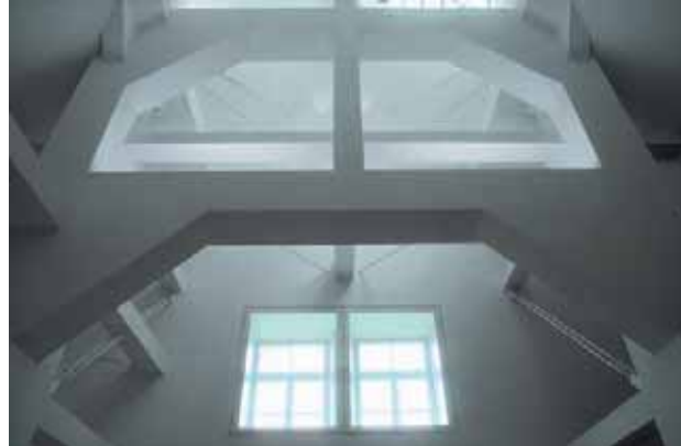
Giebelhalle © Amann Architekten BDA
