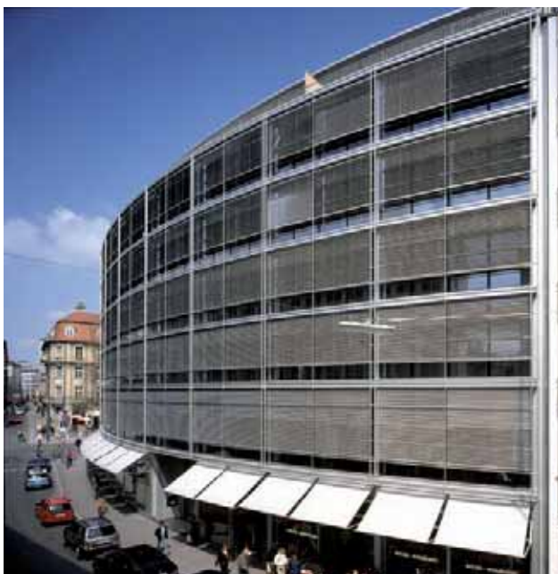
»Gekrümmte« Fassade © Simone Rosenberg
