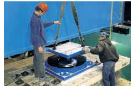
Lagereinbau auf der Erdbeben-testanlage © Maurer Söhne GmbH & Co. KG
