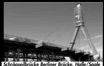
Schrägseilbrücke Berliner Brücke, Halle/Saale
